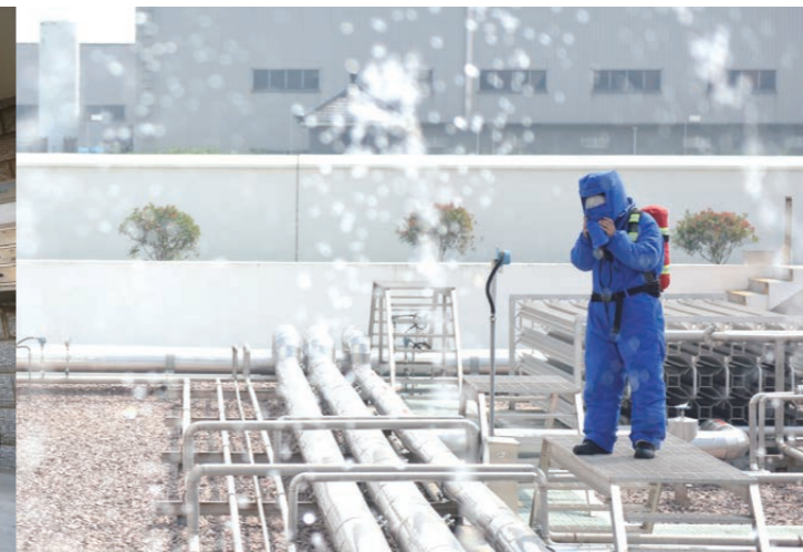
▲ 宁波区域公司开展LNG应急调峰站突发事故应急演练
