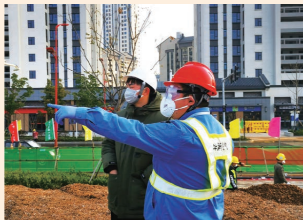
▲ 雷神山医院现场勘察
